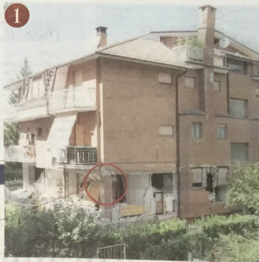
1 Casa privata in cemento armato Si tratta di una palazzina all'ingresso di Amatrice. È in piedi, ma mancando le staffe si è verificata la deformazione del nodo trave-pilastro. Questo è un caso di come la normativa esistente non sia stata rispettata: molto probabilmente la casa dovrà essere abbattuta
