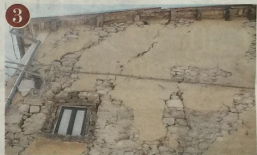
5 Interventi mancanti Nella frazione Retrosi, alcune murature sono di scarsa qualità, e manifestano lo spaccamento in avanti, dovuto a scarsa manodopera. Inoltre in alcuni edifici mancano del tutto le catene di contenimento e i cordoli in cemento armato che servono a creare il cosiddetto «effetto scatolare» che impedisce loro di crollare
