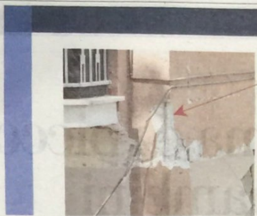
1 Casa privata in cemento armato Si tratta di una palazzina all'ingresso di Amatrice. È in piedi, ma mancando le staffe si è verificata la deformazione del nodo trave-pilastro. Questo è un caso di come la normativa esistente non sia stata rispettata: molto probabilmente la casa dovrà essere abbattuta
