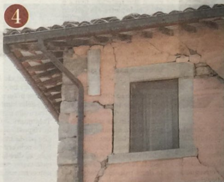
4 E quelli sbagliati In questa casa di Retrosi sono presenti catene di contenimento (la sbarra chiara verticale di acciaio) ma è stata messa nel punto sbagliato: vicino ad aperture e finestre la resistenza della muratura è minore
