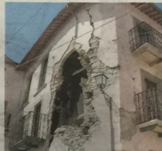
5 Interventi mancanti Nella frazione Retrosi, alcune murature sono di scarsa qualità, e manifestano lo spaccamento in avanti, dovuto a scarsa manodopera. Inoltre in alcuni edifici mancano del tutto le catene di contenimento e i cordoli in cemento armato che servono a creare il cosiddetto «effetto scatolare» che impedisce loro di crollare
